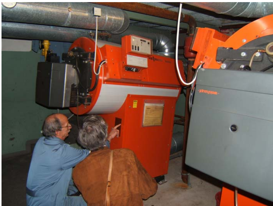
Abb. 4: Oben: Vermessung eines Gebäudes mit dem Lasermessgerät Unten: Begehung Heizungsanlage (mit Hausmeister)
